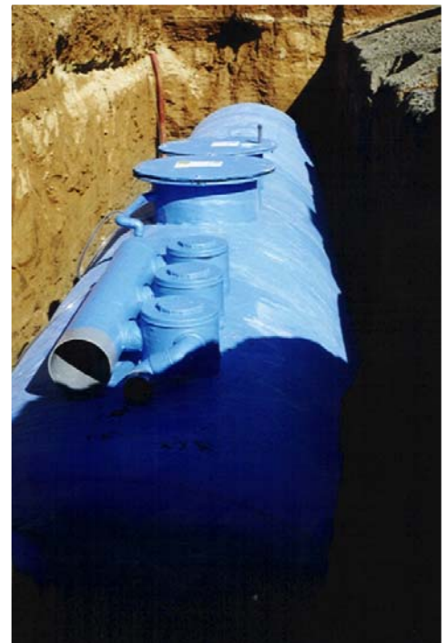
Depósito de recogida de aguas grises y pluviales. (Foto: Ecoagua)
