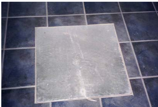
Deposito-arqueta en vivienda unifamiliar (Foto: Ecoaigua)
