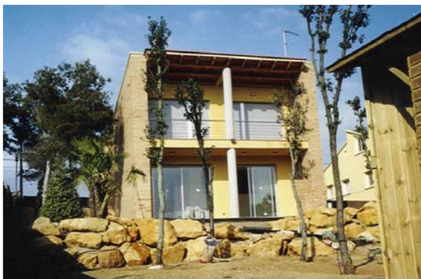
Vivienda unifamiliar con sistema de reutilización de aguas grises. (Foto: Ecoaigua)
