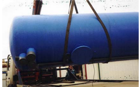
Instalación del depósito-depuradora entre (Foto: Ecoagua)
