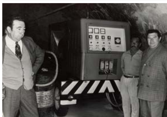
Motores diésel generadores de corriente eléctrica instalados en Nueva Tabarca, en el día de su inauguración, el 24 de diciembre de 1963 (Fotos: Archivo Municipal de Alicante).
