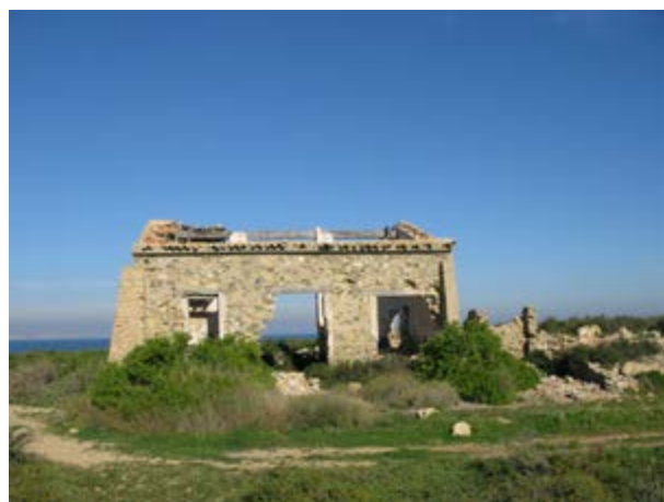
Vista del inmueble en su estado actual (Foto: del autor).
