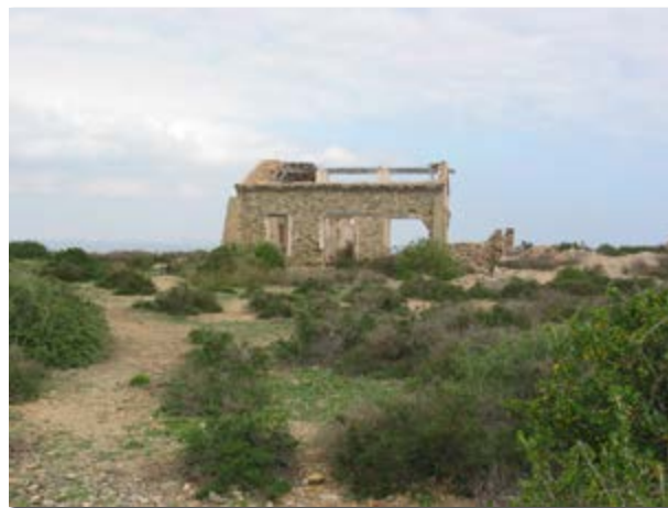
“Cortijo” actualmente (Foto: del autor).
