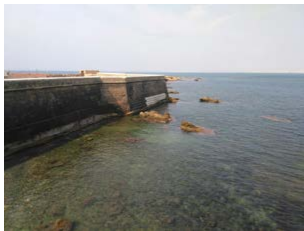
Tramo de muralla restaurado. Baluarte de la Princesa (Foto: del autor).
