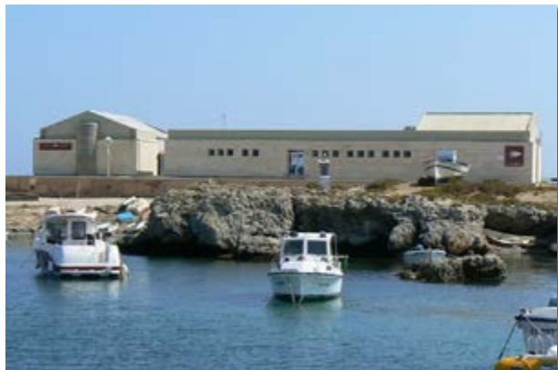
Sede del Museo Nueva Tabarca, Edificio de Servicios de la Isla, en el antiguo almacén de la almadraba (Foto: del autor).
