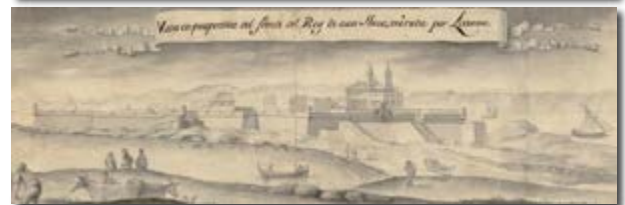
Perspectiva desde el este, donde se aprecian los baluartes de San Pedro y San Pablo, la tenaza doble de Aranda, así como los garitones esquinados. Arriba, perfil de la muralla (extraído del plano de Méndez, 1774).
