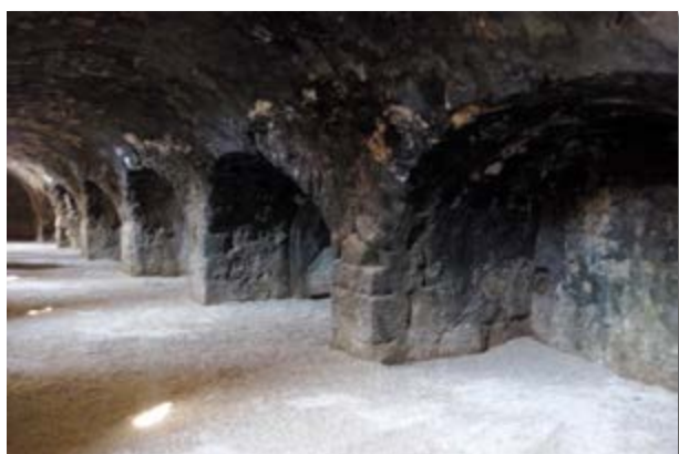
Situación de los almacenes de artillería (según el autor) e interior actual. (Foto: del autor).
