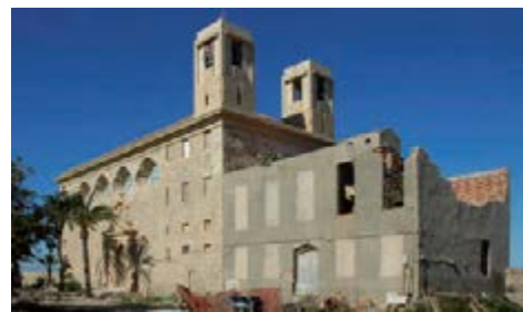
La Iglesia con la Casa Parroquial, en 1998 y en 2012, tras la primera fase de restauración del templo. Se observa el galopante deterioro del edificio anexo, necesitado de urgente restauración (Fotos extraídas de MARTÍNEZ MEDINA, 2012, p. 144-145).
