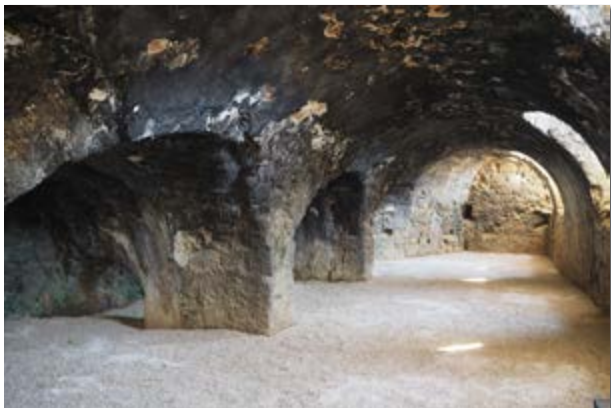
Bóvedas de artillería, por debajo del Baluarte de la Princesa, en el perfil noroeste de la muralla (Foto: del autor).
