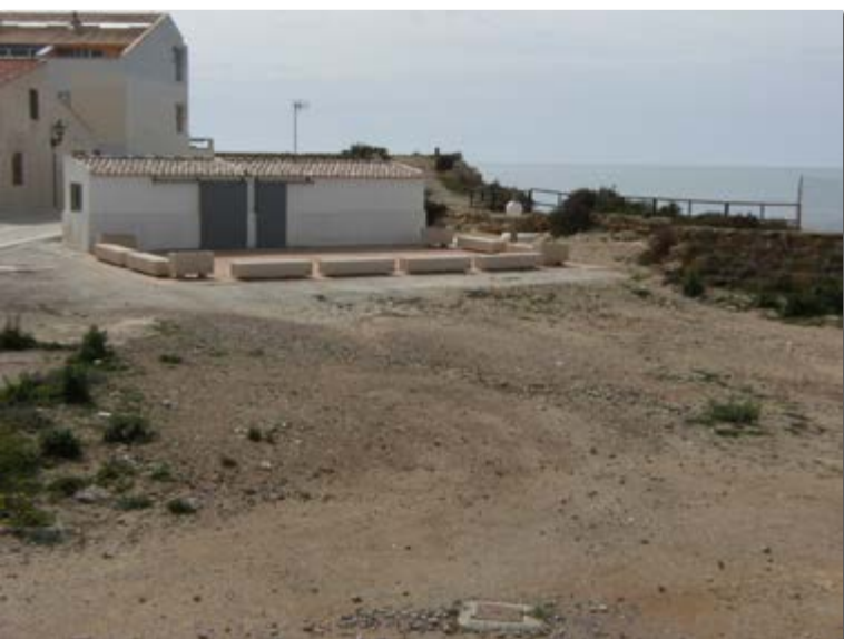
Instalación actual de la depuradora en la Plaza de Baillencourt (Foto: del autor).
