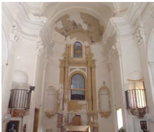
Restauración del altar de la Iglesia en las obras ejecutadas en 2015 (Foto: Encarni Rabadán).
