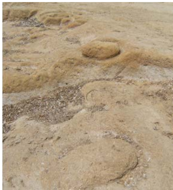
Detalle de sillares originales sin extraer en el suelo de calcarenitas de La Cantera (Foto: del autor).
