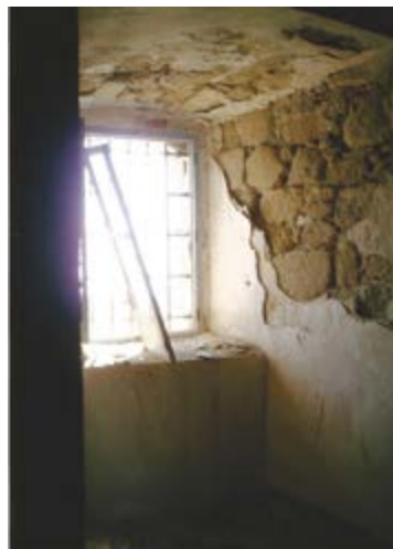
Varios puntos del interior del inmueble, donde se observa parte de la estructura del edificio (Fotos: Francisco Garbi).
