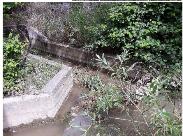
Lugar de incorporación de las aguas del embalse de las Cañas a la acequia.
