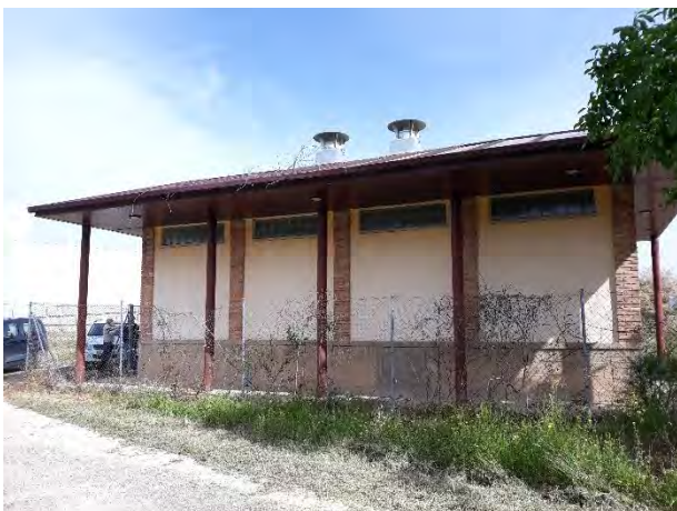
Caseta de bombeo
