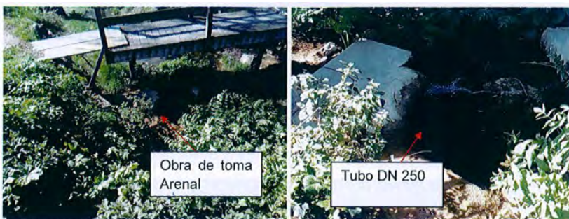
Obra de toma del Arenal
