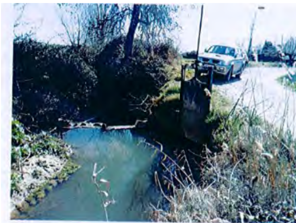
Derivación Azud del río Perezuelas a la balsa.
