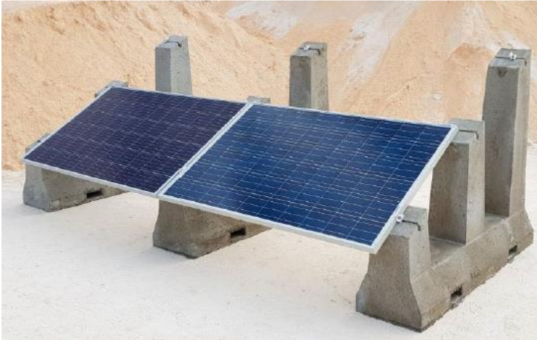
Figura 6. Detalle soporte paneles solares
