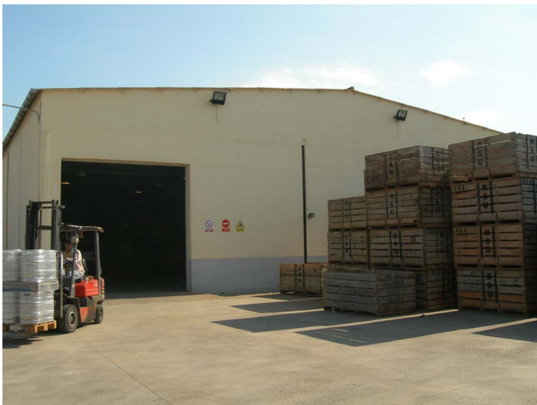
Instalación central hortofrutícola, clasificadora y envasadora de patatas. Mallorca
