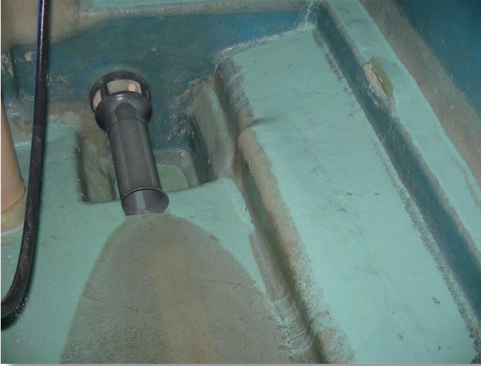
Sedimentos en el fondo del depósito como consecuencia de un mal funcionamiento del sistema de agitación
