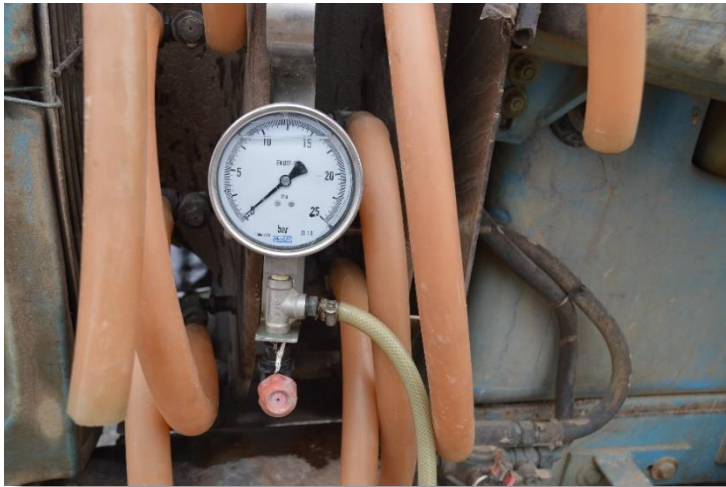
Instalación de los manómetros para la medida de la caída de presión en un pulverizador
