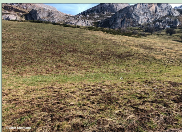
4. Daños en Valle del Lago (Somiedo)
