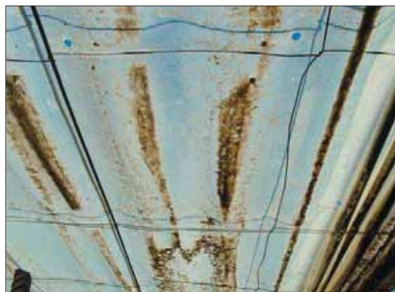
*Fotografía N° 9. Sistema de alambres en el techo del invernadero*
