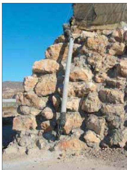
*Fotografía N° 18. Tubería de salida del agua de lluvia del invernadero*
