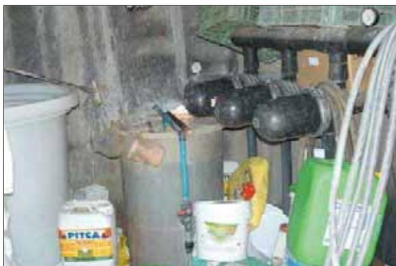
Fotografía N° 19. Depósito para mezcla manual de fertilizante
