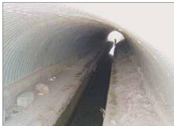
*Fotografía N° 53. Túnel bajo la autovía para el paso del Canal*
