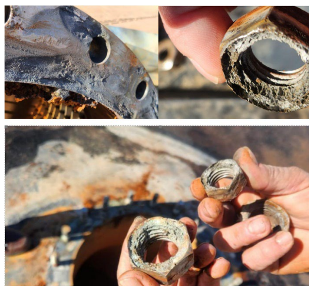
Fig. nº 14-B. Erosiones piezas de acero inoxidable.
