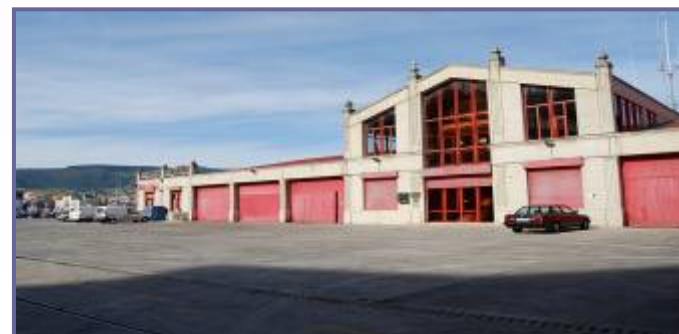
Vista exterior de la Lonja de Pescado de Bermeo.
