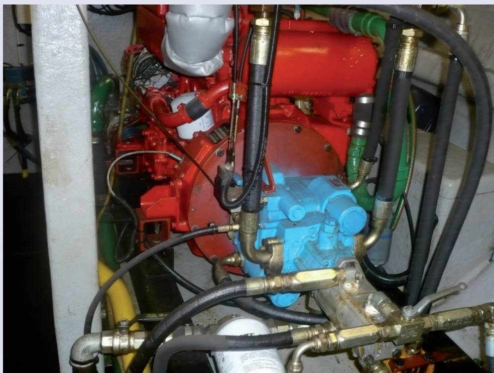
Figura 17. Grupo auxiliar hidráulico
