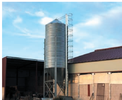
SILO Y ALMACÉN DE MATERIAS PRIMAS
