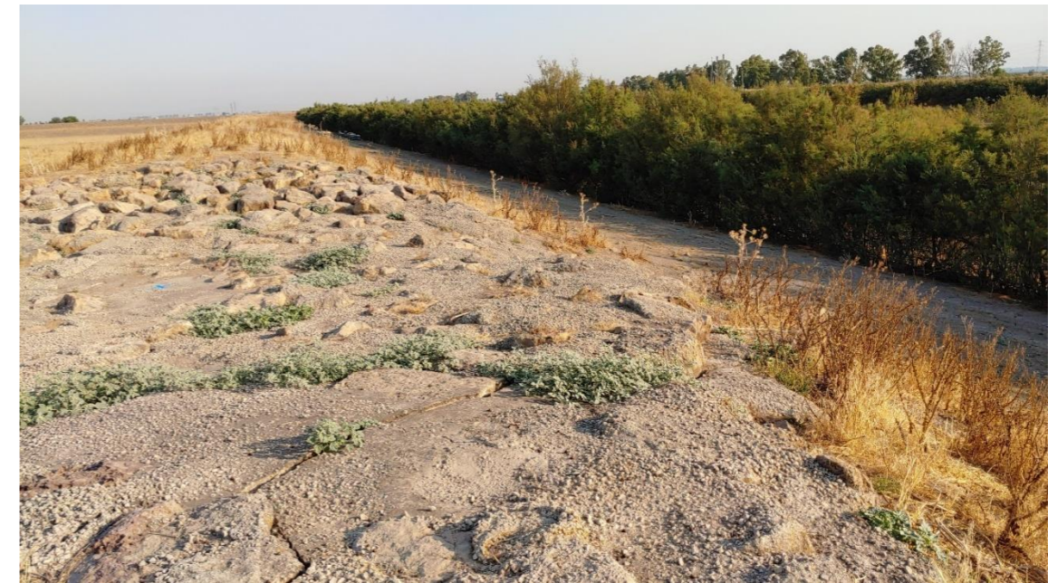
Figura 16. Estado actual de la Balsa de Decantación (1)
