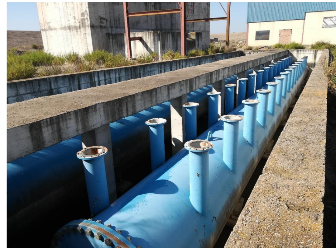
Imagen 21. Vista general de la obra civil. Estación de filtrado.
