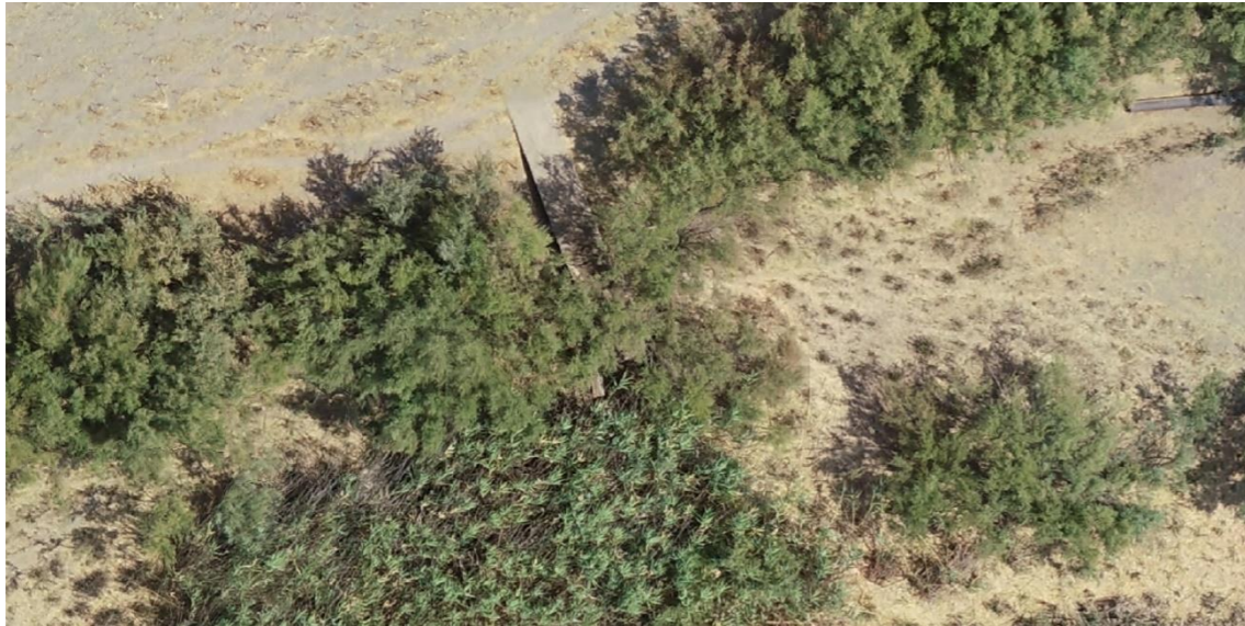
Figura 22. Vista general del estado actual de la obra de toma del desagüe de fondo de la Balsa de Regulación
