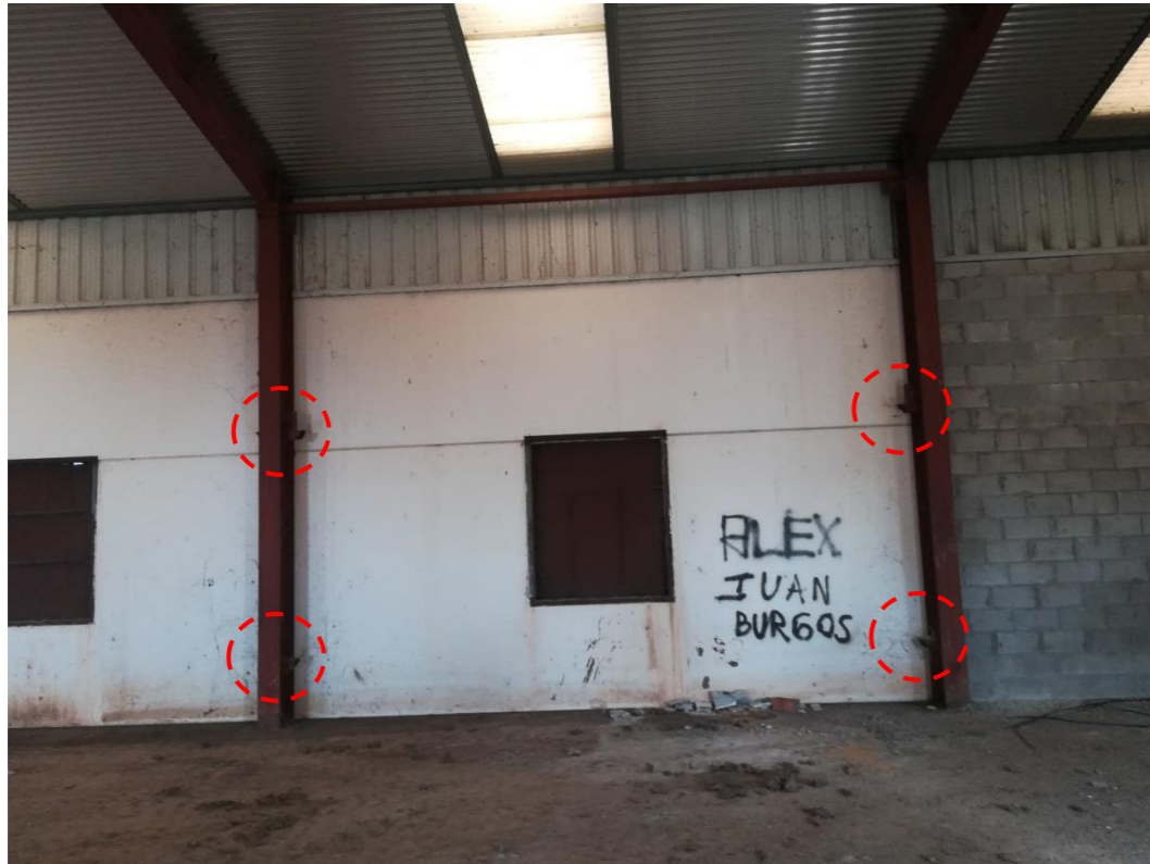
Fotografía 6: Foto del estado actual de la estructura metálica de la nave de la estación de bombeo. Se indican los cortes realizados a la estructura original de la nave.
