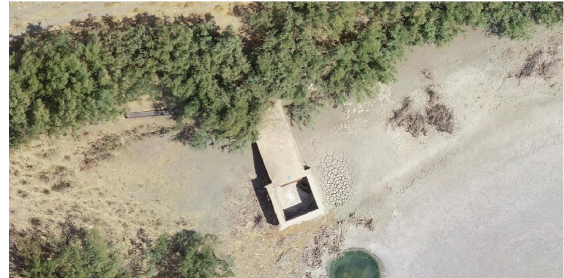
Figura 20. Vista general del estado actual de la obra de toma de la aspiración desde la Balsa de Regulación
