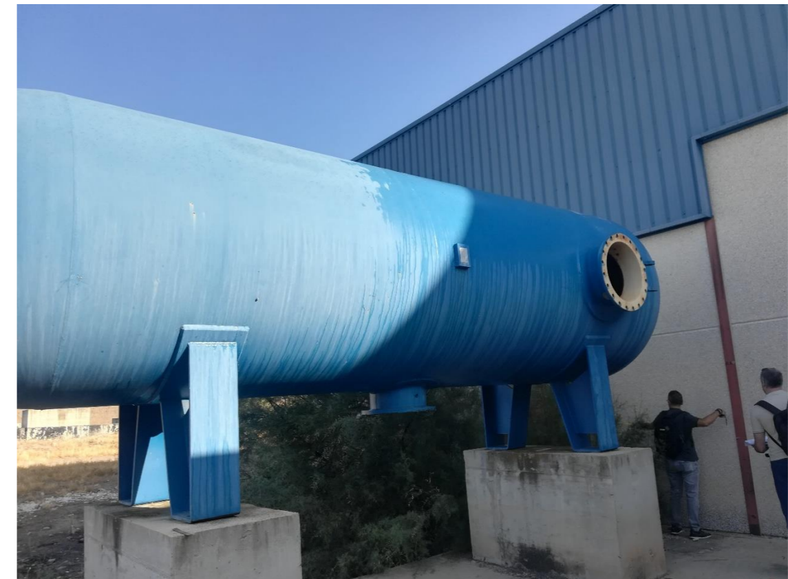
Fotografía 7: Foto del estado actual de la estructura metálica de la nave de la estación de bombeo. Se indican los cortes realizados a la estructura original de la nave.
