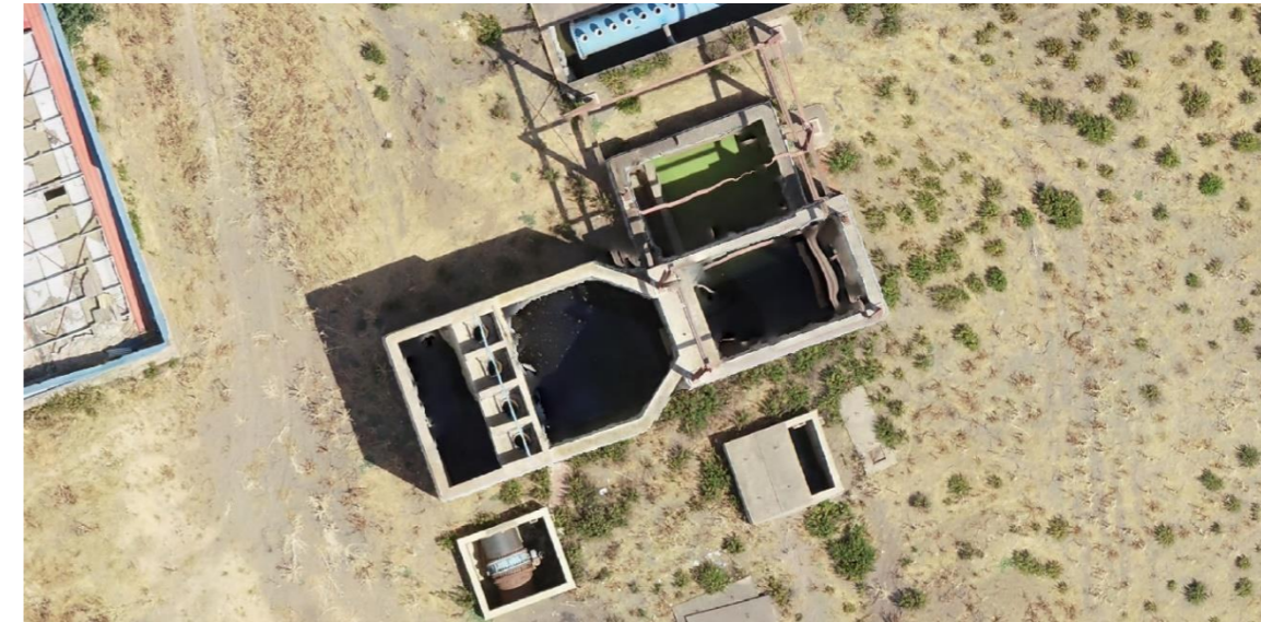
Figura 9. Vista general del estado actual de la estación de bombeo de llenado de las balsas (1)
