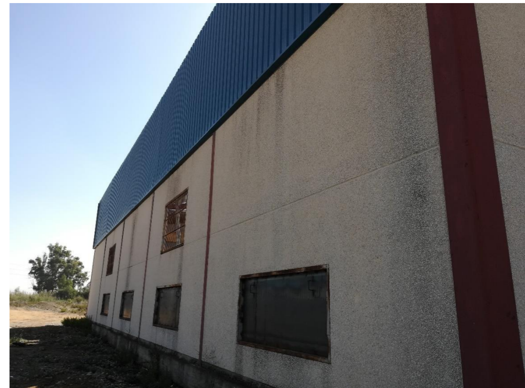
Imagen 7. Rejas, tapiado de huecos de ventilación y huecos de ventanas. Alzado oeste de la estación de bombeo principal.
