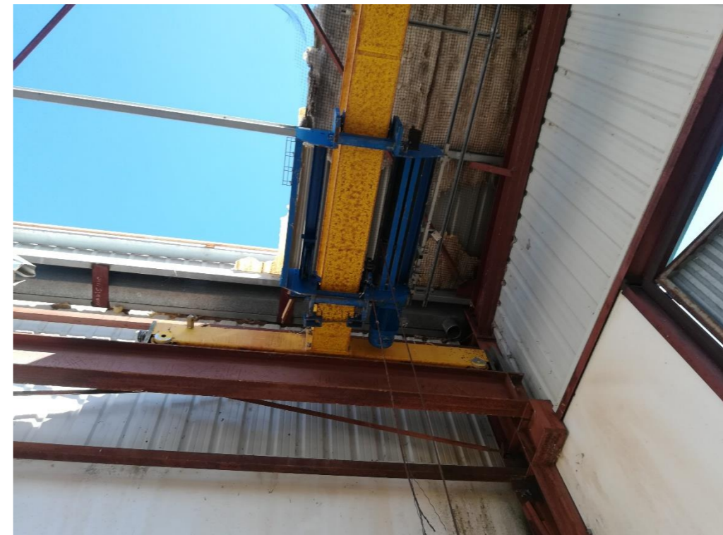
Imagen 19. Estado actual puente grúa. Estación de bombeo principal (2).
