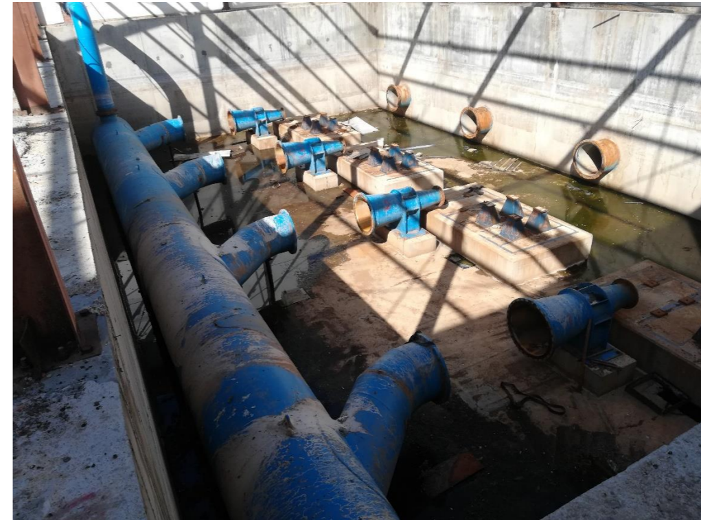
Imagen 12. Vista general del foso de bombeo. Estación de bombeo principal (2).
