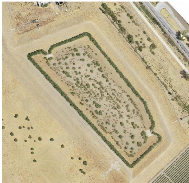
Figura 15. Vista general del estado actual de la Balsa de Decantación
