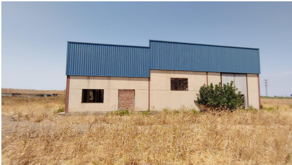
Imagen 3. Vista general del estado actual de la estación de bombeo para riego EB-2 (2).
