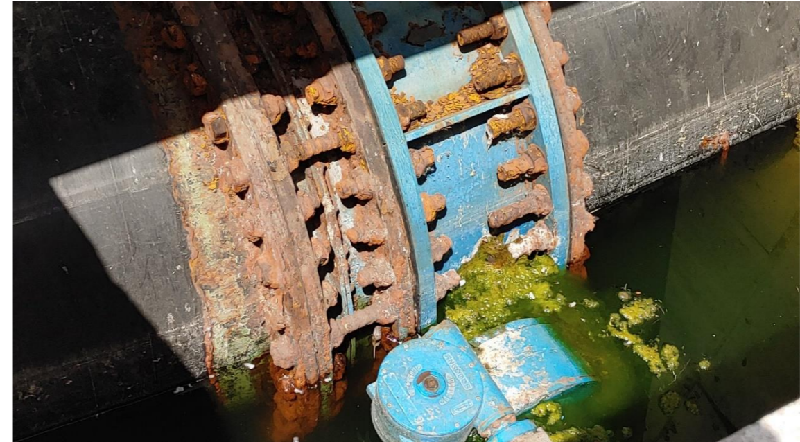
Figura 11. Estado actual de la Arqueta V.M. 3 (2)
