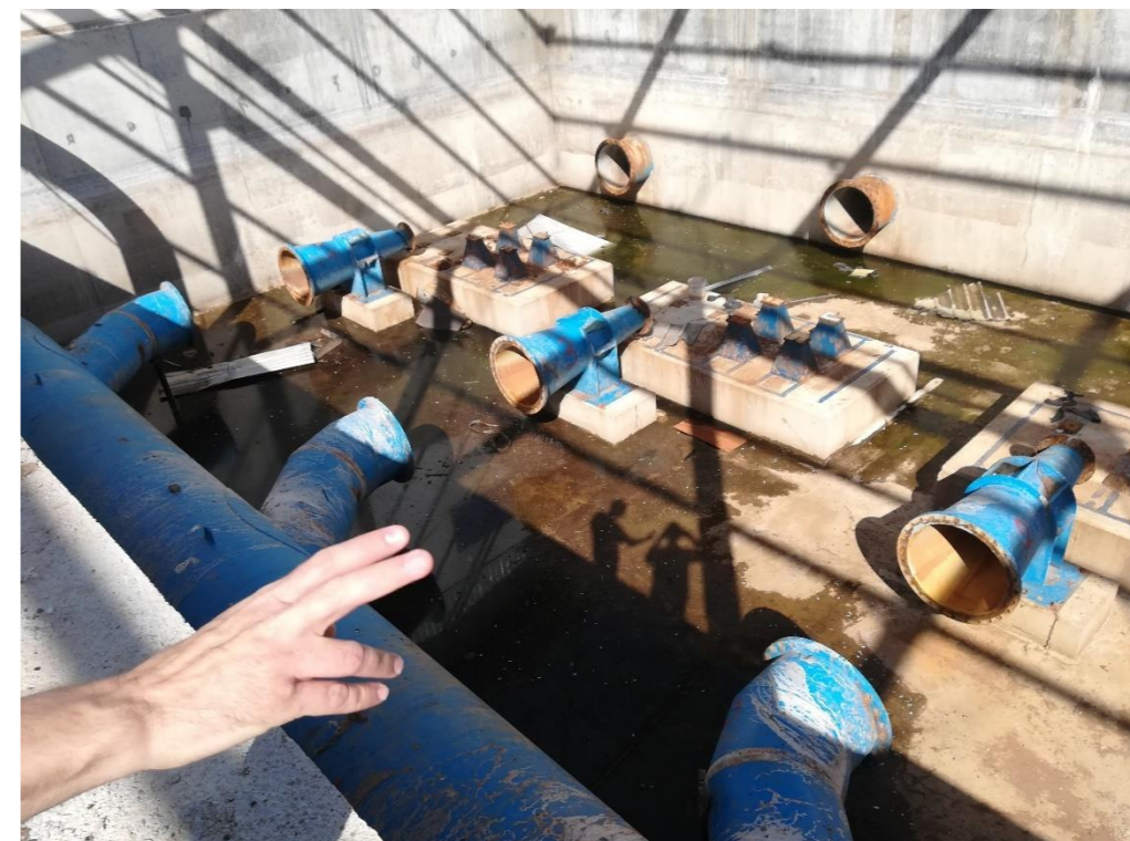
Imagen 13. Vista general del foso de bombeo. Estación de bombeo principal (3).
