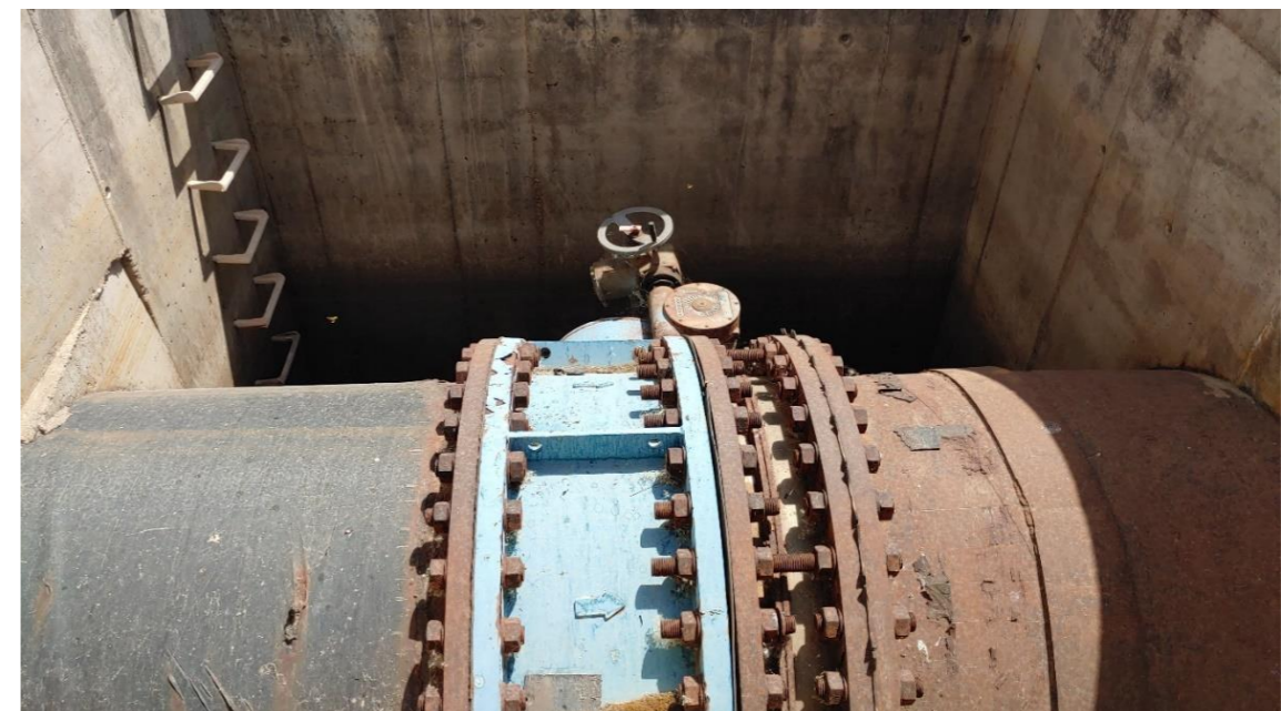
Figura 12. Estado actual de la Arqueta V.M. 4 (2)
