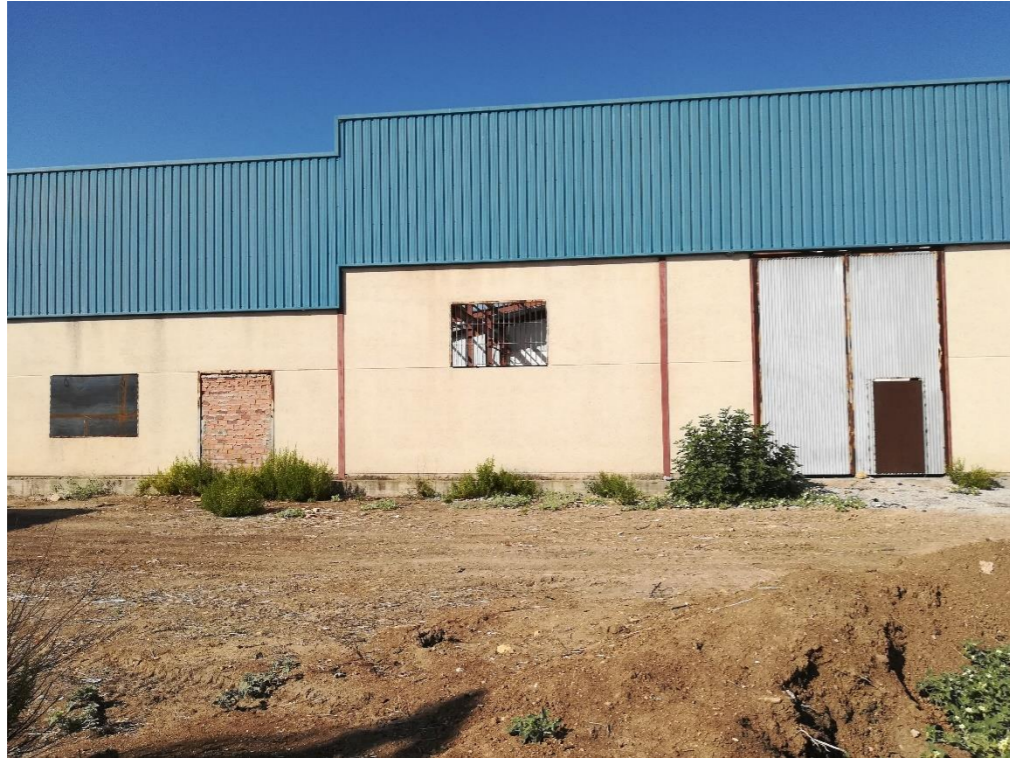
Imagen 4. Puerta de acceso principal y tapiado de ventanas y puertas. Alzado norte de la estación de bombeo principal.
