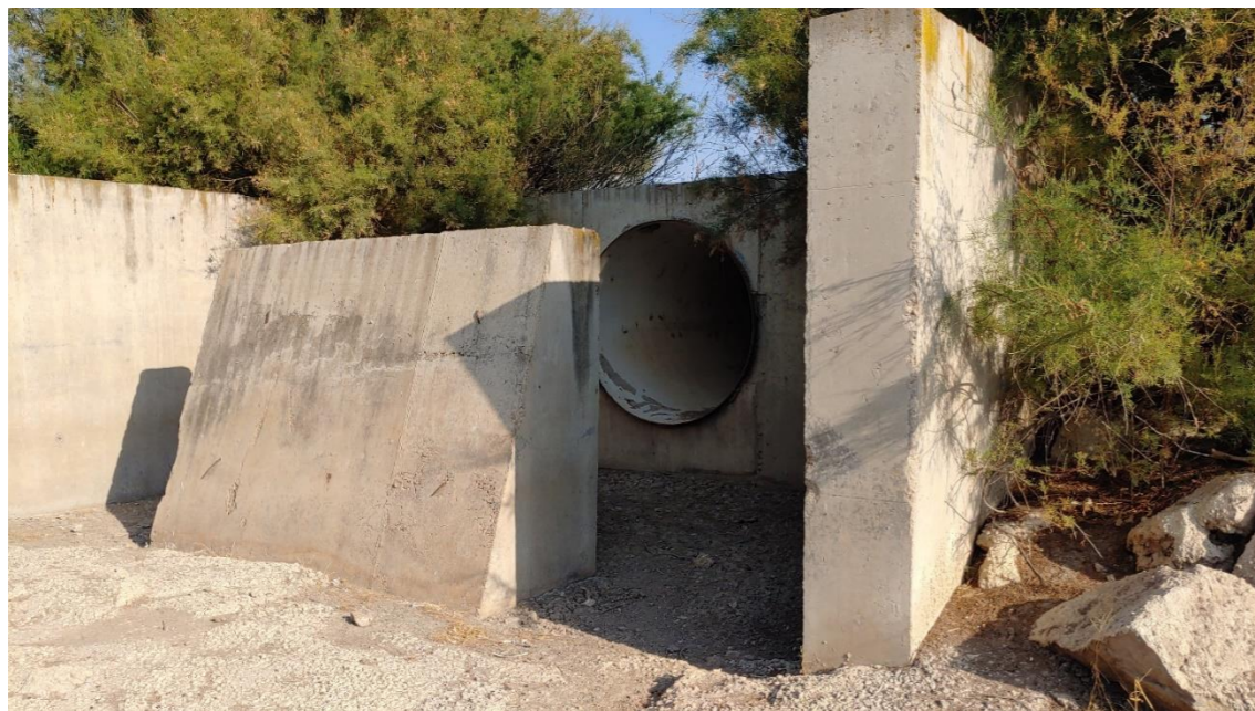
Figura 17. Estado actual de la obra de toma y descarga de la Balsa de Decantación (2)
