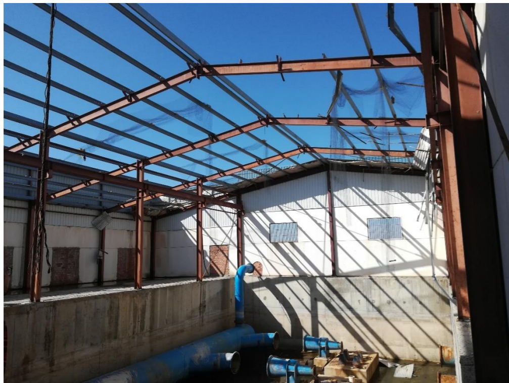
Imagen 11. Vista general del foso de bombeo. Estación de bombeo principal (1).
