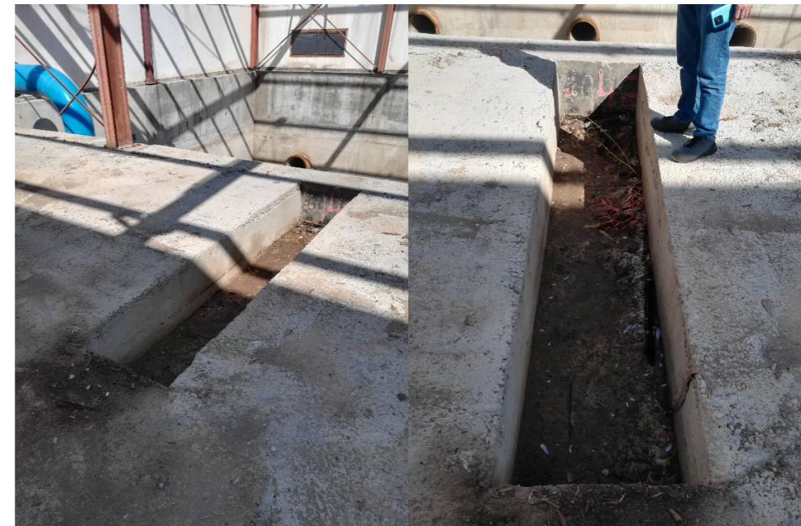
Imagen 10. Huecos ejecutados en solera de la estación de bombeo principal.
