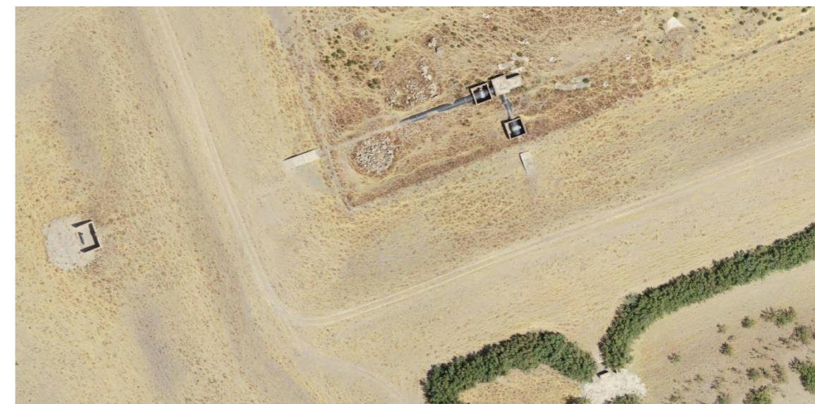
Figura 14. Vista general de los colectores de conexión entre balsas y la estación de bombeo de llenado
