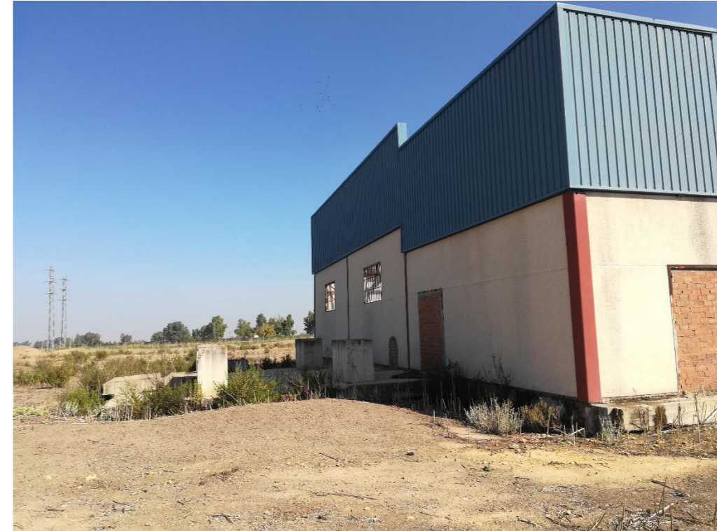
Imagen 6. Ventanas y tapiado de puerta de acceso y huecos de tubuladuras. Alzado sur de la estación de bombeo principal.
