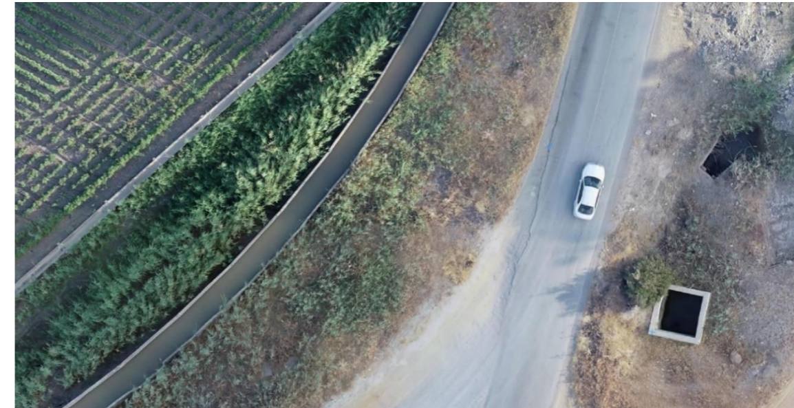
Figura 1. Vista general del estado actual de la zona de ubicación de la obra de toma en CD-1
