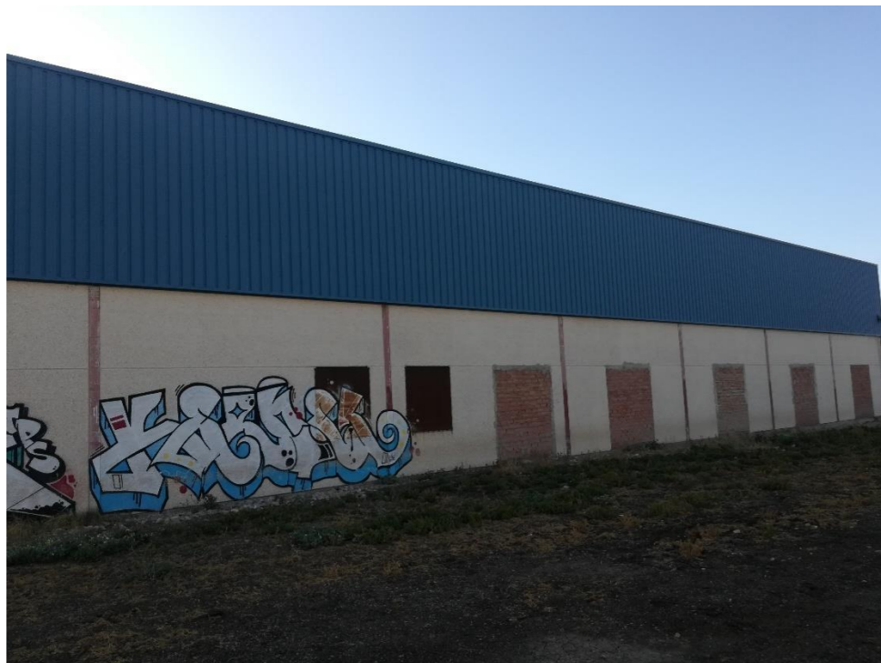
Fotografía 1: Vista lateral norte del edificio de la estación de bombeo
