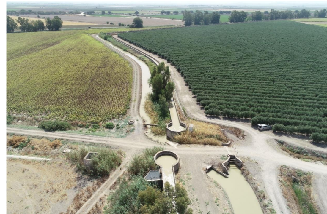
Figura 3. Vista general del estado actual de la obra de toma en CD-2
