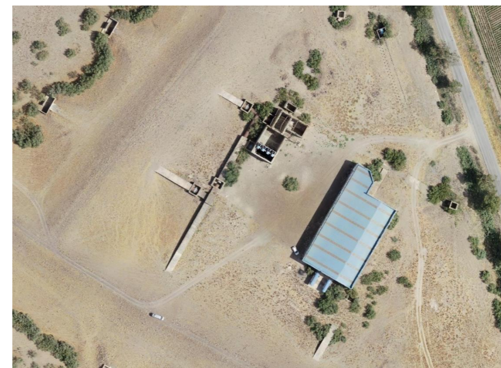
Figura 5. Vista general del estado actual de los colectores de conexión
