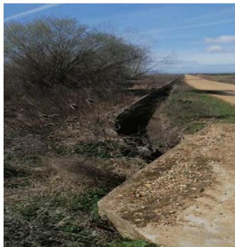
*Imagen 52. Sistema de riego actual. Infraestructuras y red de distribución. Acequia.*
