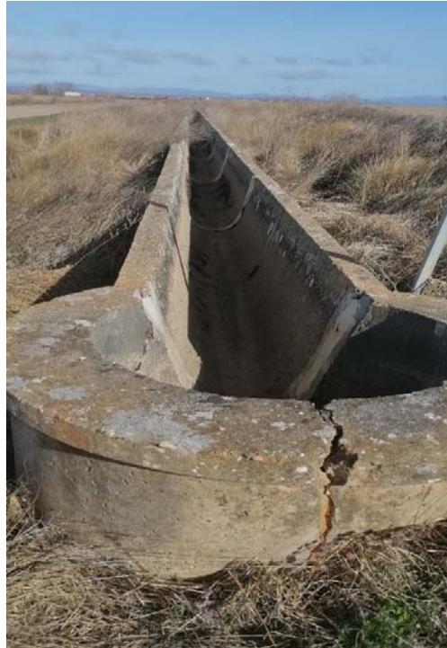
*Imagen 6. Acequia deteriorada. Red de riego existente.*
