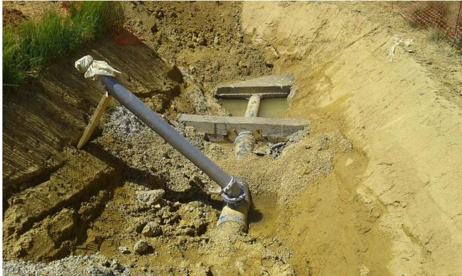
Imagen 83. Salida tipo de tubería a hidrante (45°). Salida tipo de tubería a hidrante (45°).
