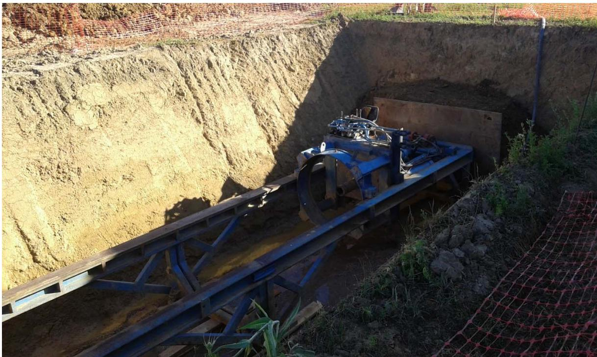
*Imagen 81. Perforación horizontal (hinca) en obra tipo de modernización de regadío.*
