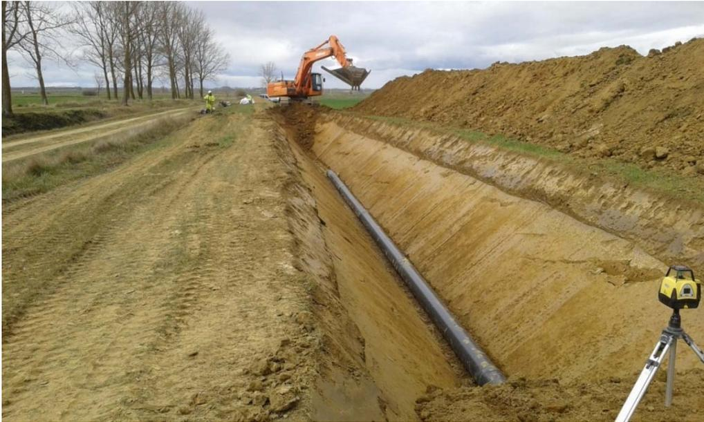
*Imagen 79. Excavación para tubería en obra de modernización de regadíos.*
