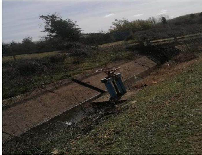
*Imagen 54. Sistema de riego actual. Infraestructuras y red de distribución. Toma directa en canal para salida a riego*
