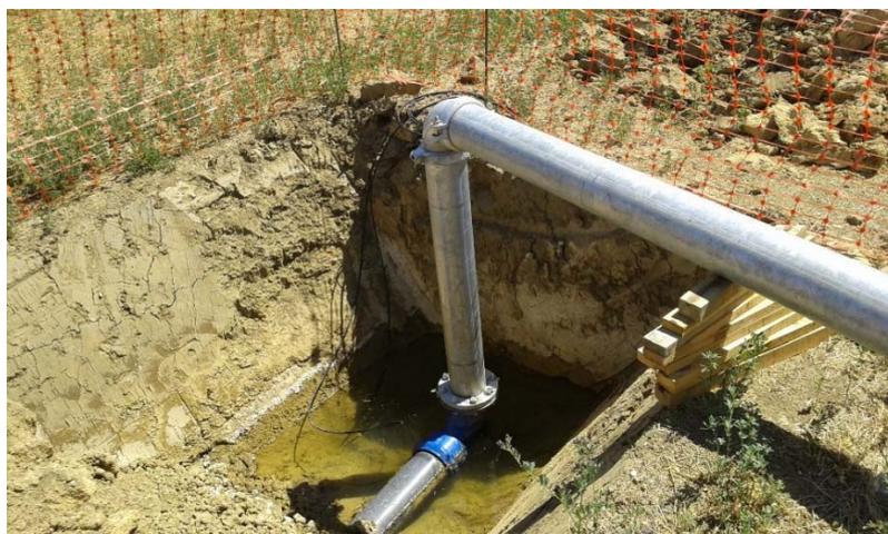
Imagen 82. Salida tipo de tubería a hidrante (90°).
