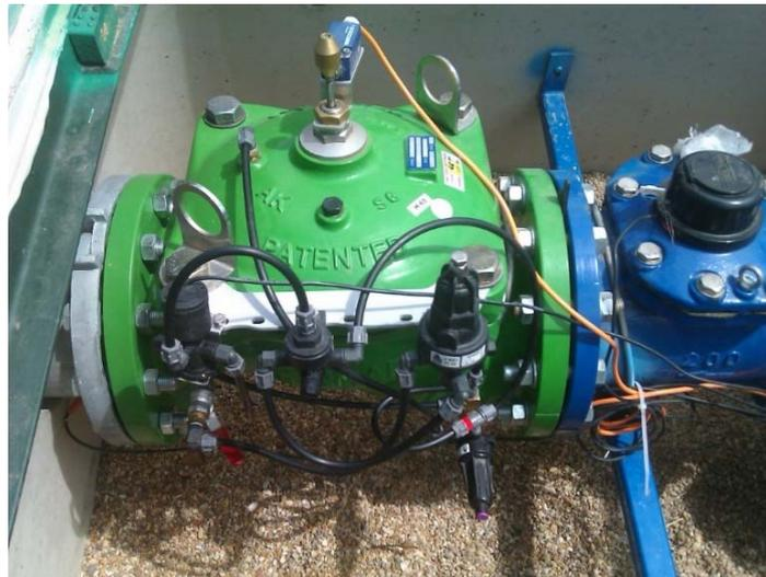
Imagen 84. Válvula hidráulica albergada en hidrante.
