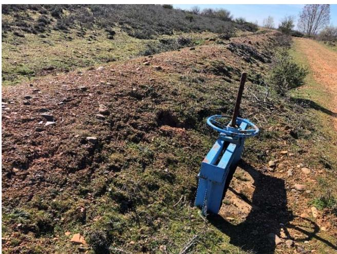
*Imagen 39. Compuerta de toma directa del Canal de Villadangos para salida a red de riego (acequias)*
