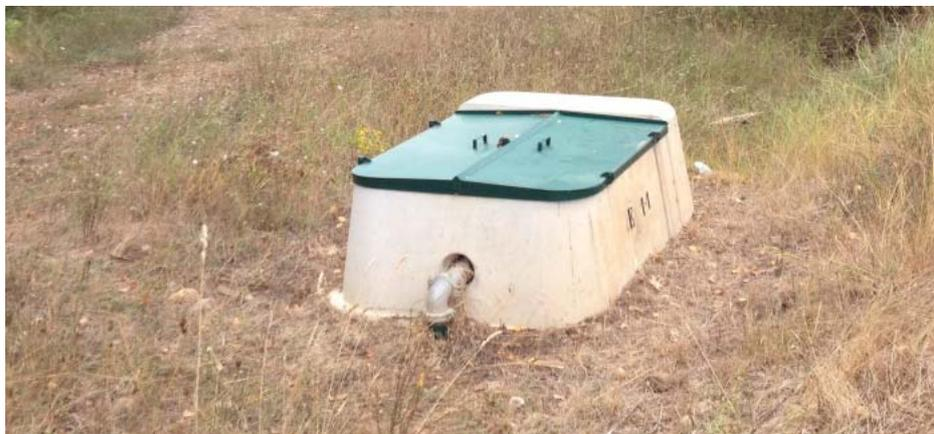
Imagen 85. Hidrante tipo instalado en campo en obra de modernización de regadíos, en zona de Castilla y León.
