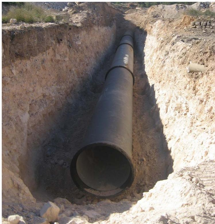
*Imagen 80. Excavación e instalación de tubería en obra de modernización de regadíos.*
