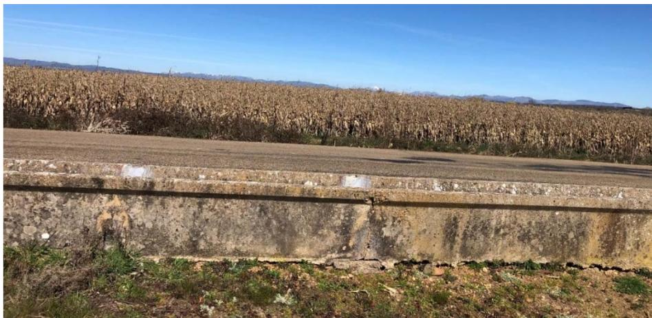
*Imagen 61. Estado de la infraestructura de riego (Acequia de hormigón) dentro de la zona regable.*
