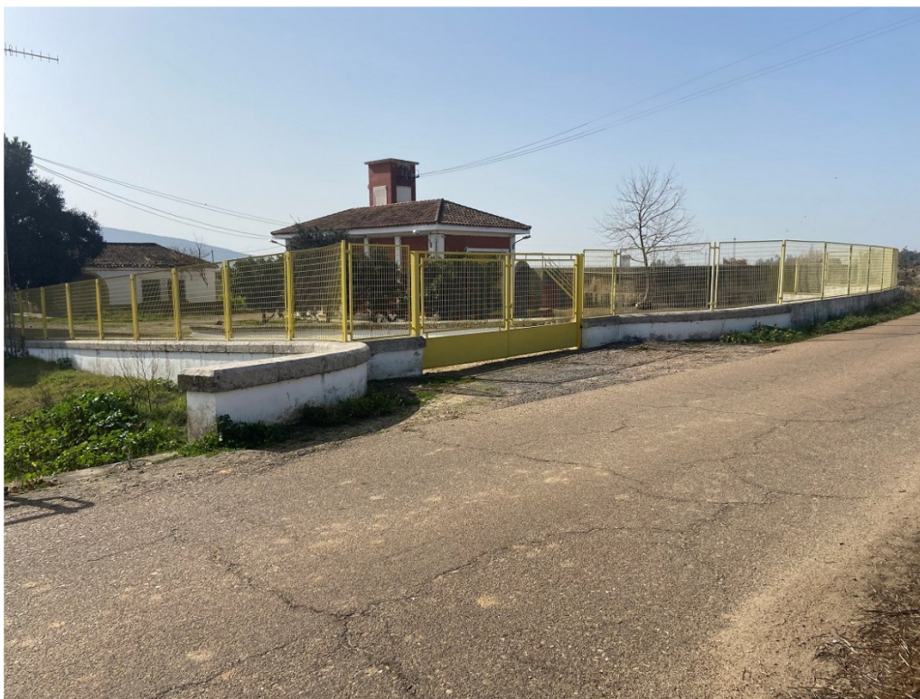
Fotografía 2. Acceso a estación de bombeo sector A
