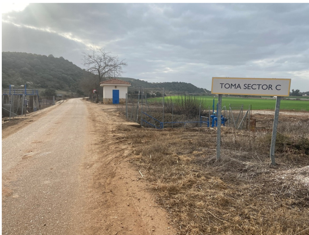
Fotografía 3. Camino de servicio acceso campo fotovoltaico-estación de bombeo sector B
