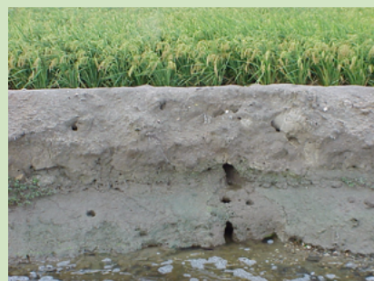
3. Margen con entradas de galerías
