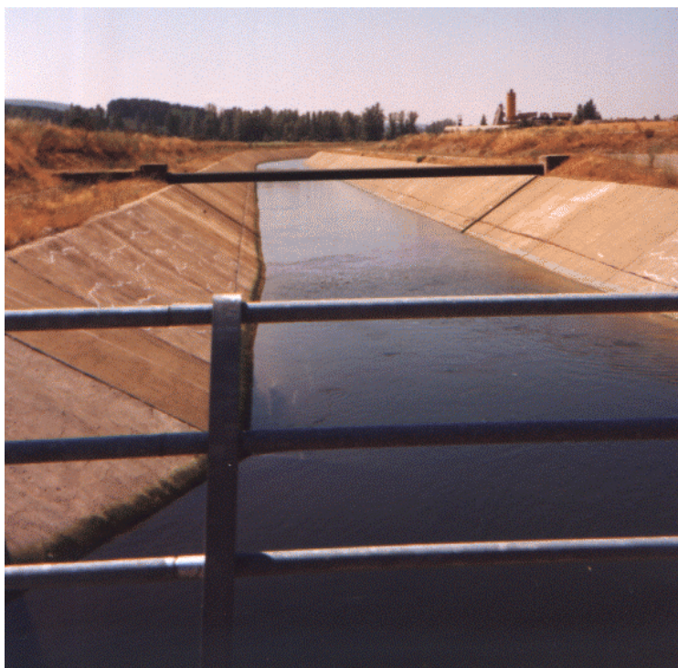
Foto 7: Comienzo del Canal Alto de Payuelos sobre el río Esla
