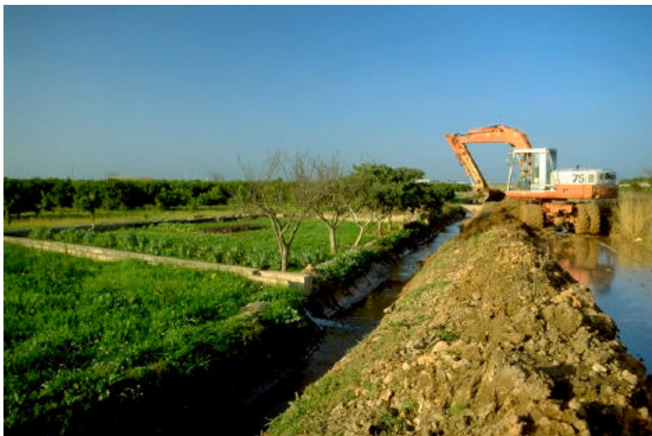
Foto 9: Acequia en construcción
