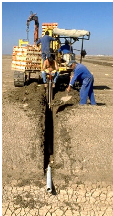
Foto 11: Drenaje en construcción
