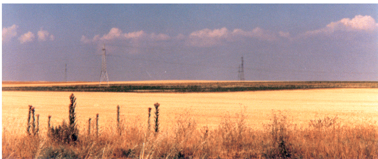
Foto 3: Torres de tendidos eléctricos en Payuelos
