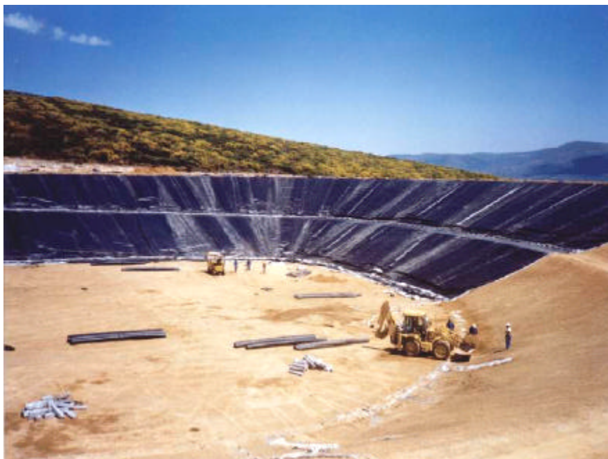
Foto 6: Balsa de riego en construcción
