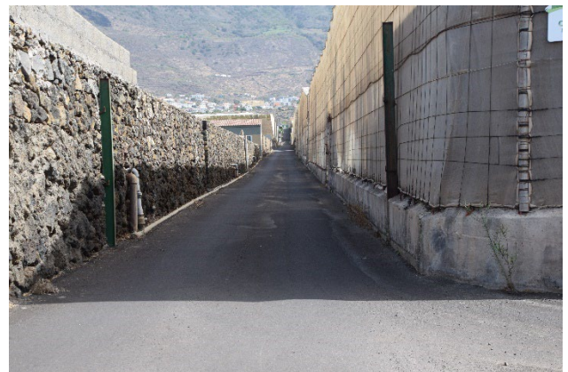
Foto 37. Viario de acceso a finca
