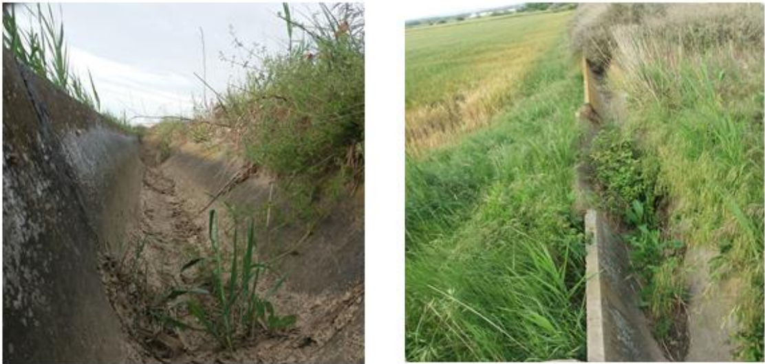
Imagen 1: Fotografías de las acequias de canaletas prefabricadas actuales para la distribución de agua.
