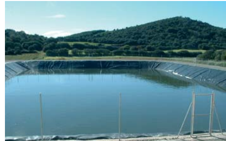
Figura 4. Almacenamiento purín en balsa.
