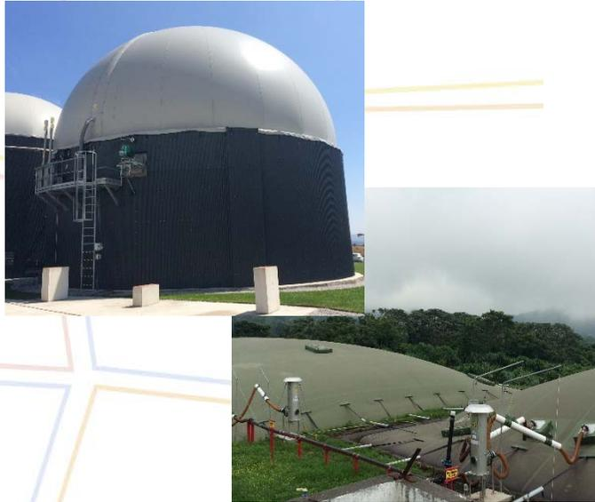
A) Digestión Anaerobia “*Digestores Verticales*” vs. “*Digestores de laguna*”
