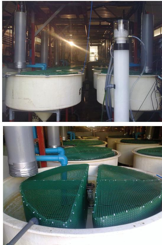
**Fotografía 4. Circuito actual del pulpo donde se observan los tanques y la espumadera para limpieza de sólidos.**
