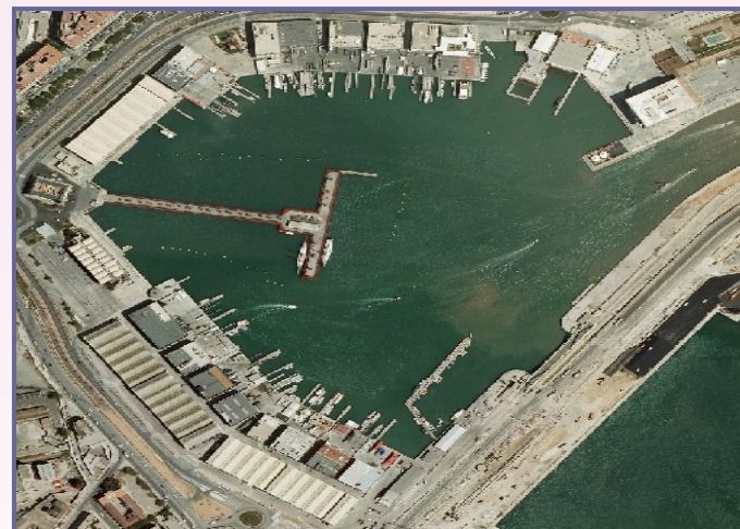
Fuente: Fondo Español de Garantía Agraria. Vista aérea del puerto pesquero de Valencia.
